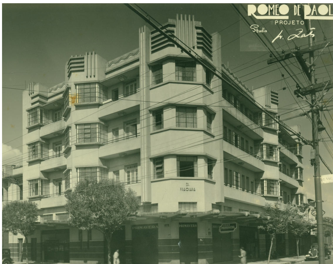
Fonte: Museu Histórico Abílio Barreto (2024a). Figura 8. Edifício Piraquara (Hotel Gontijo).
