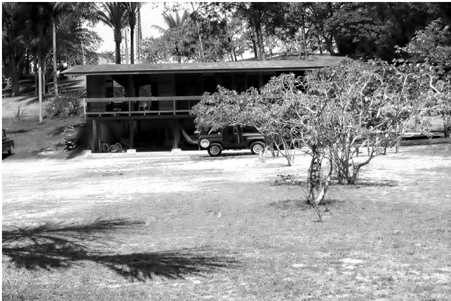
Fonte: Cereto (2020, p. 177). Figura 3. Casa do Cafundó.
